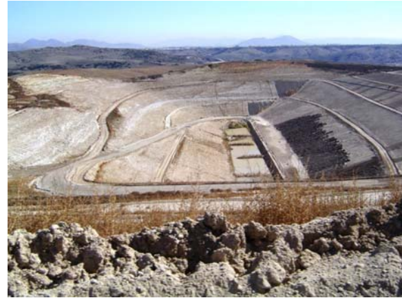
Otay County Landfill
