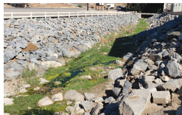
其他活动 — 堤岸保护/稳固、道口建设、堤防建设和其他采用机械化施工的活动。
