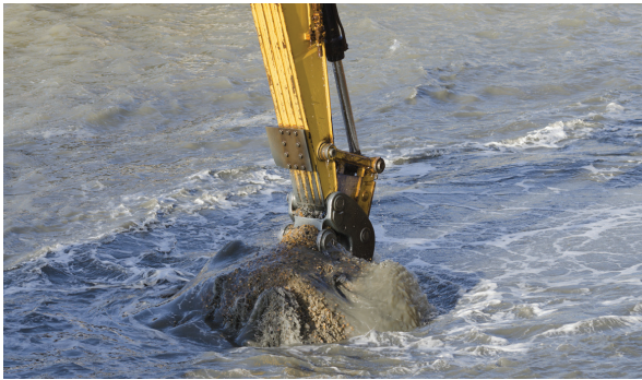
لایروبی — خارج کردن رسوب و سایر مواد از کف پهنه‌های آب.
