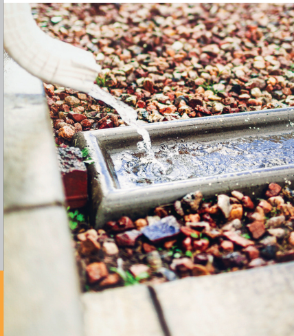
落水管和導水槽
