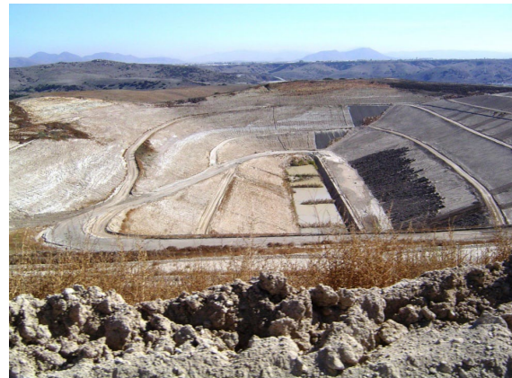
Otay County Landfill
